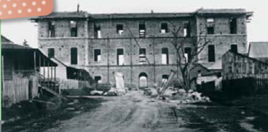
Hôpital en cours de construction, Coll. Bibliothèque Bernheim
