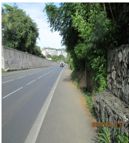
Reprise des trottoirs des rampes de la chaussée - rue A. BENEBIG Vallée des Colons
