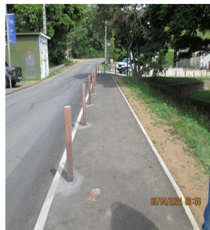
Reprise du cheminement - Avenue James COOK - Nouvelle
