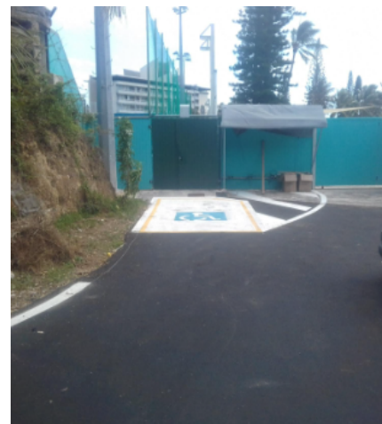
Réfection de la route d'accès PMR et ambulance de la piscine Jacques MOUREN
