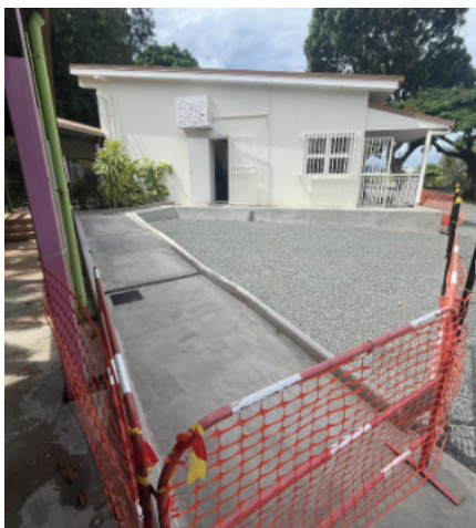
Rampe d'accès à l'école DUPONT
